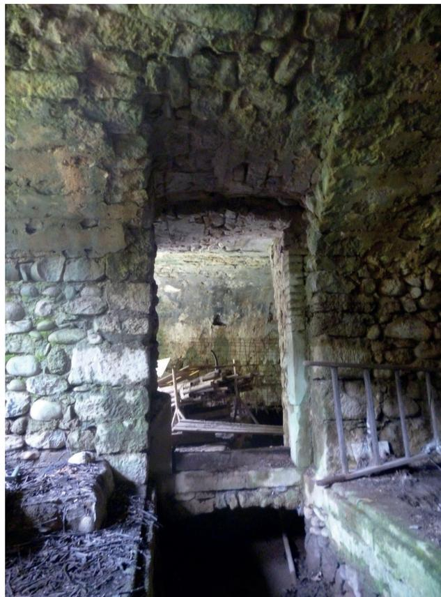
*Passage du canal du Plot dans la tannerie. On y lavait les peaux dans l'eau courante, à l'abri.*
