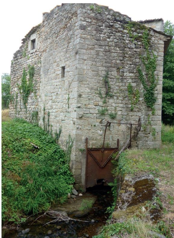
*Arrivée de l'eau au moulin, à la sortie du "grand canal". La vanne-guillotine est bien visible.*
