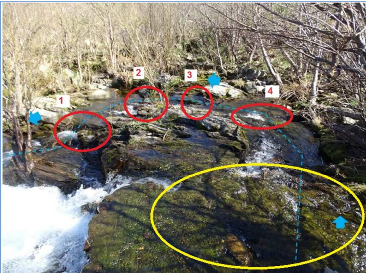
Figure 24 : Configuration du contournement rive droite. Les quatre petits seuils sont numérotés de l'aval vers l'amont de 1 à 4 (cercles rouges) et le parement incliné final est cerclé de jaune (source : Dynamique Hydro et ARALEP).
