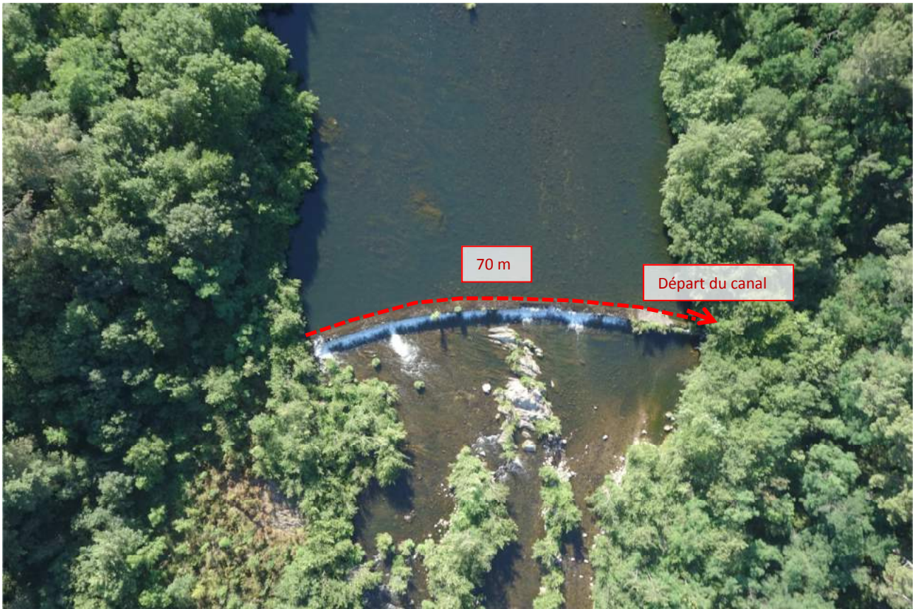
Figure 5 - Photographies du seuil
