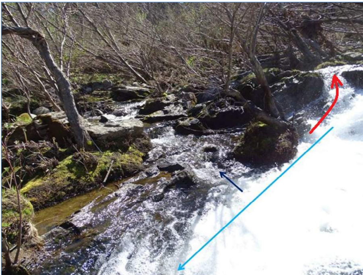
Figure 26 : Détail du débit d'attrait (cascade d'écume ; cf. flèche bleu clair) et de l'entrée du contournement (cf. flèche bleu foncé) (source : Dynamique Hydro).
