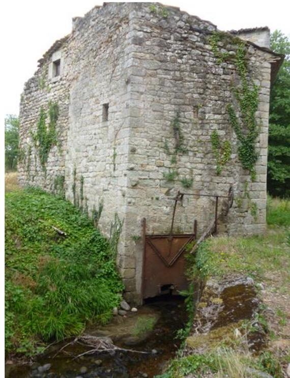
*Arrivée de l'eau au moulin, à la sortie du « grand canal ». L'éperon et ses « pierres à bosses ». La vanne-guillotine permettant de dévier au besoin le courant avant le moulin est encore bien visible.*
