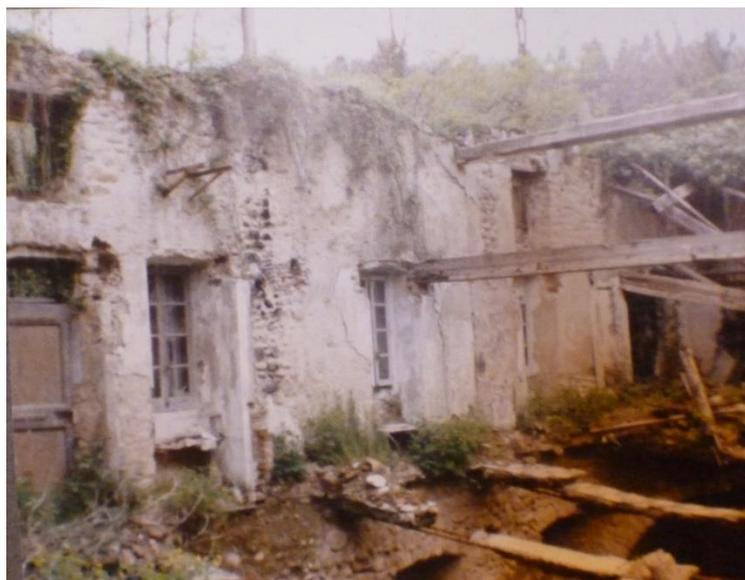
*Ruines du moulinage dans les années 60 (photo J.-C. Bonnaud). On distingue trois niveaux : celui de la machinerie (hydraulique puis électrique) au sous-sol ; celui des machines à torser le fil ; celui du logement des ouvrières en haut.*
